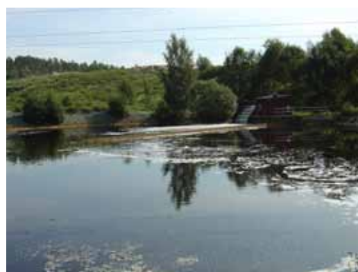
Lakvattendamm vid deponianläggning.
