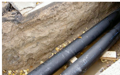
Miljökontroll i samband med schakt- och ledningsarbeten. Provtagning, analys och bedömning av jord, vatten och asfalt.
